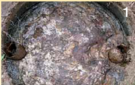
Sådan ser din bundfældningstank ud, før den bliver tømt.
